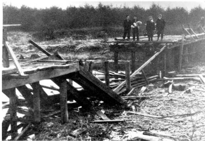
Die von den Sowjets am 21. November 1956 zerstörte Brücke von Andau
